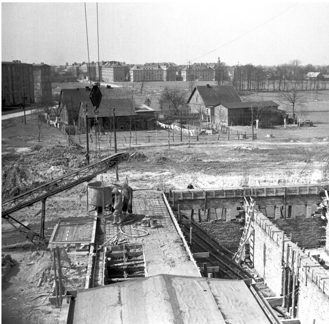
Fot. 3. Budowa Technikum Budowlanego przy ul. Engelsa (obecnie ul. Edukacji), w tle stare gospodarstwo oraz Osiedle B, okolice roku 1960. ( muzeum.tychy.pl )
